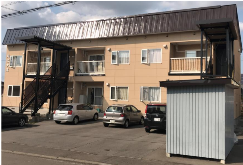
※図面等は現地状況と異なる場合があります。現況を優先となります。
